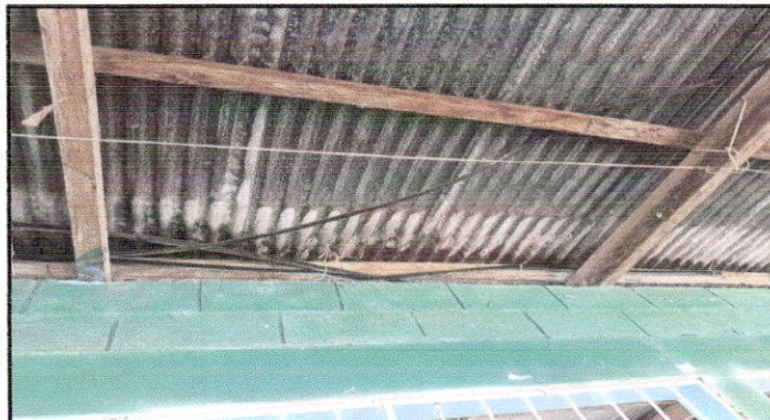
Foto 2: sustitucion de lamina por lamina troquelada calibre 26, y sustitucion de de soporte de metal por metal
