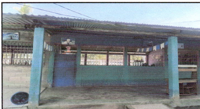
Foto 3: sustitucion de lamina por lamina troquelada calibre 26, y sustitucion de de soporte de metal por metal
