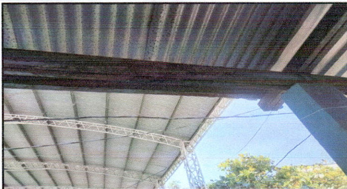
Foto 1: sustitucion de lamina por lamina troquelada calibre 26, y sustitucion de de soporte de metal por metal
