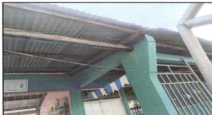
Foto 4: sustitucion de lamina por lamina troquelada calibre 26, y sustitucion de de soporte de metal por metal
